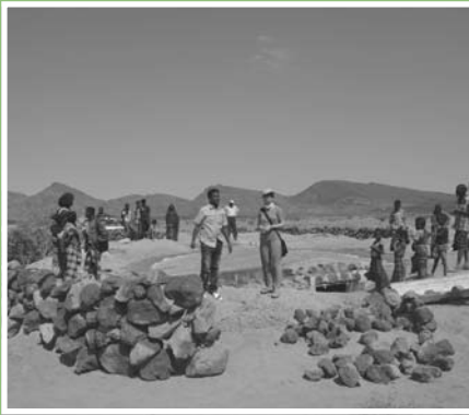
Die fertiggestellte Zisterne soll helfen, dass Familien während der Trockenzeit vor Ort bleiben können und somit der Schulbesuch für die Kinder nicht unterbrochen wird.
