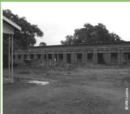
Der Bau des Grundschulgebäudes im Südsudan schreitet voran, so dass die „Schule unter den Bäumen“ bald der Vergangenheit angehören wird.
